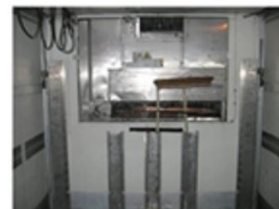
PREDMETI NA ČELU HLADNJAČE/ NA USISU ZRAKA
