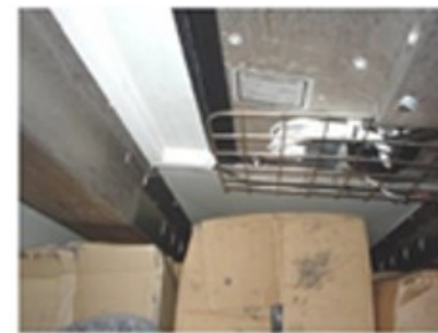
PREDMETI NA ČELU HLADNJAČE/ NA USISU ZRAKA
