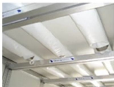
OŠTEĆEN-PROBUŠEN TUNEL
